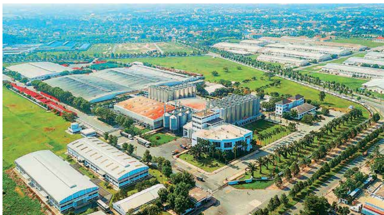
Hệ thống điện năng lượng mặt trời mái nhà tại Nhà máy Bia Sài Gòn - Quảng Ngãi của SABECO
